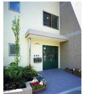
モダンで洒落たエントランス、建物は耐震・耐火対策も万全
