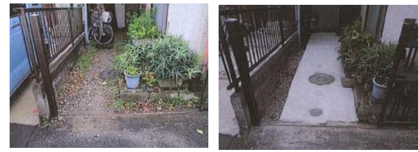
BEFORE く玄関アプローチの舗装く AFTER 歩幅にあわせた庭石等は車いすの走行に不向きです、玄関から道路・駐車場まで舗装すると走行がスムーズになります。
