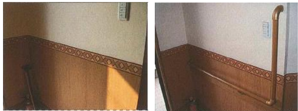
BEFORE く玄関すりの設置く AFTER 出っ張りが少なく玄関が狭くなりません。壁に向かってR状になっているので衣類をひっかける危険を防止します。
