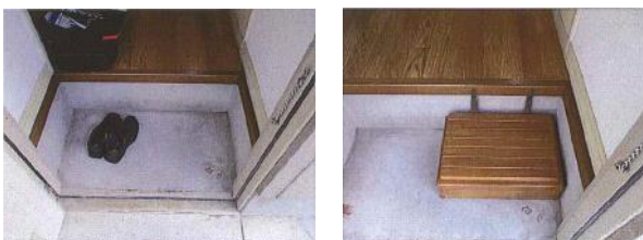
BEFORE く玄関ステップの設置く AFTER 上がり框（かまち）に約半分の段差ステップを取り付け安心して昇り降りができるようになります。
