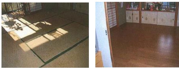
BEFORE く床材の変更く AFTER 畳の床をフローリングに変更。歩行車や車いすのキャスターが沈み込むのを解消し、より安全な移動が可能になりました。
