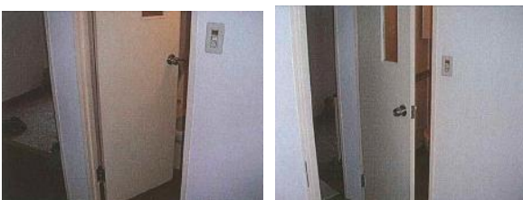
BEFORE く扉開閉方向の変更く AFTER 実は危険な内開きドアの中で倒れるとドアが開けられなくなり出ることが出来なくなりますから安心の外開きへ。
