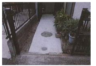
BEFORE <玄関アプローチの舗装> AFTER 歩幅にあわせた庭石等は車いすの走行に不向きです、玄関から道路・駐車場まで舗装すると走行がスムーズになります。
