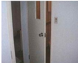
BEFORE <扉開閉方向の変更> AFTER 実は危険な内開きドア＜中で倒れるとドアが開けられなくなり出ることが出来なくなります＞から安心の外開きへ。
