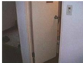
BEFORE <扉開閉方向の変更> AFTER 実は危険な内開きドア＜中で倒れるとドアが開けられなくなり出ることが出来なくなります＞から安心の外開きへ。
