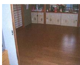
BEFORE <床材の変更> AFTER 畳の床をフローリングに変更。歩行車や車いすのキャスターが沈み込むのを解消し、より安全な移動が可能になりました。
