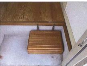
BEFORE <玄関ステップの設置> AFTER 上がり框（かまち）に約半分の段差ステップを取り付け安心して昇り降りができるようになります。
