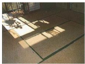
BEFORE <床材の変更> AFTER 畳の床をフローリングに変更。歩行車や車いすのキャスターが沈み込むのを解消し、より安全な移動が可能になりました。
